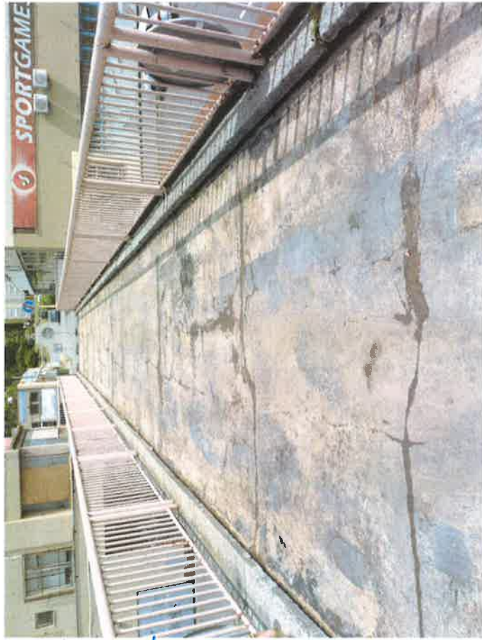
Odstraněný povrch litého asfaltu z mostovky
