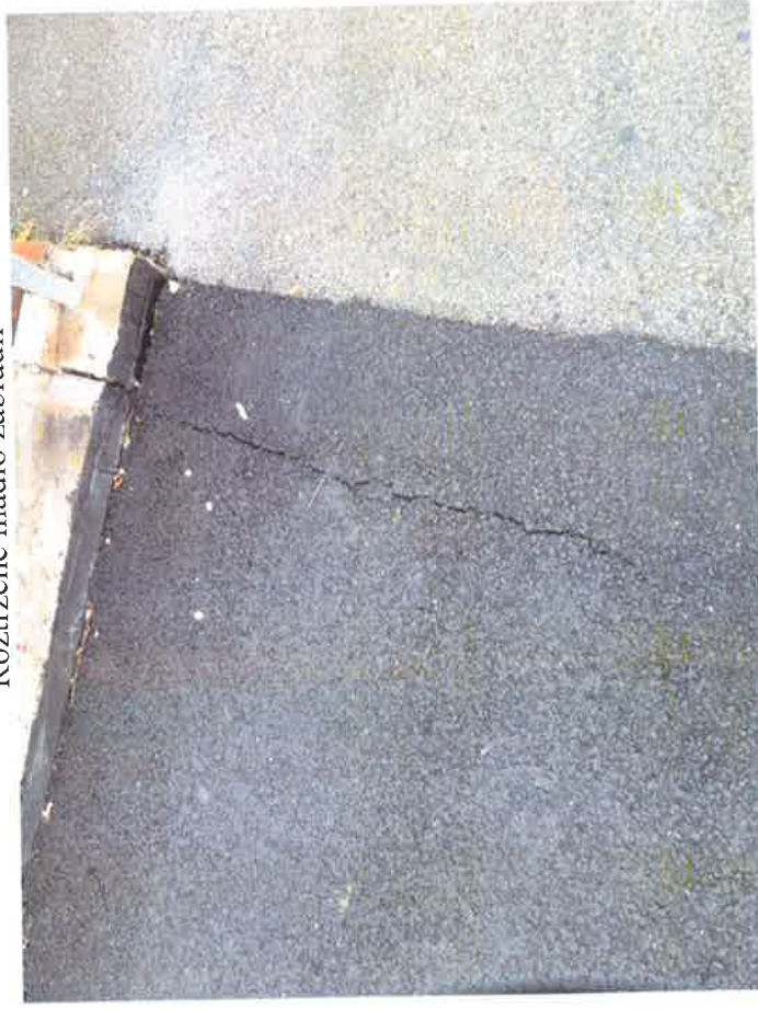
Příčná trhлина v živичném krytu mostovky
