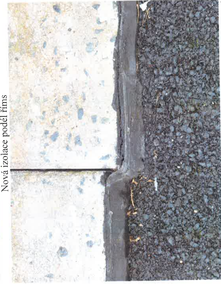
Zatěsnění podél římsy vlevo
