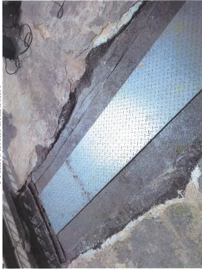
Ocelové plechy přes dilatační spáru
