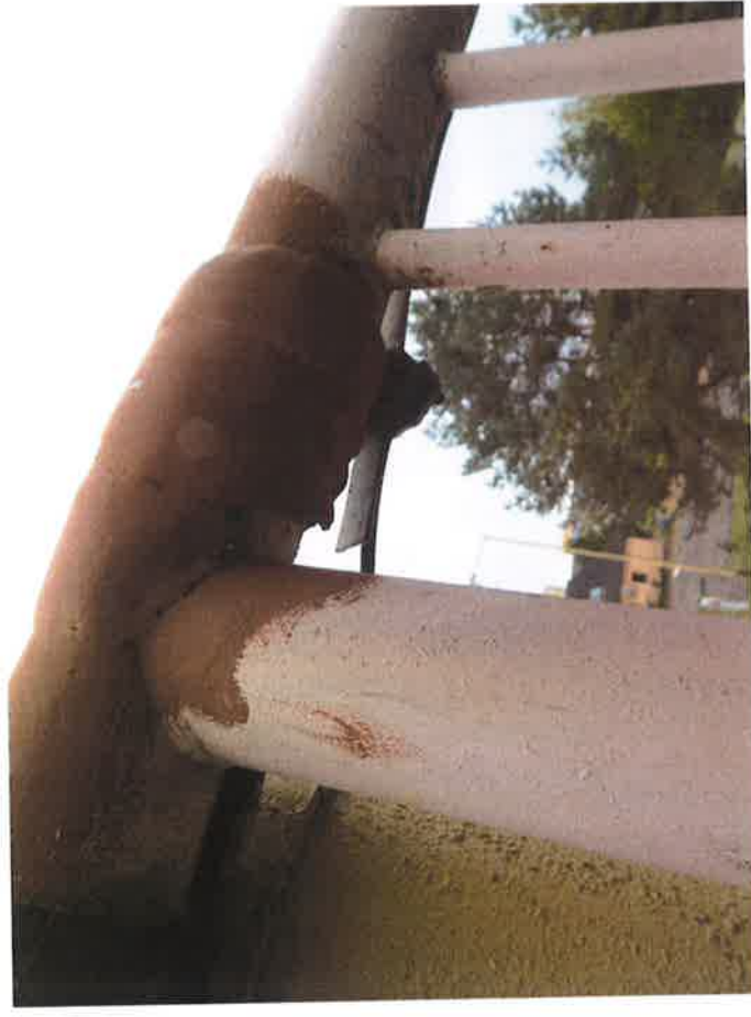
Roztržené madlo zábradlí
